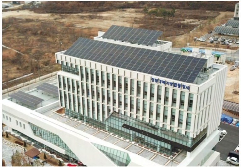
정부경북지방합동청사 관공자체 방송설비
