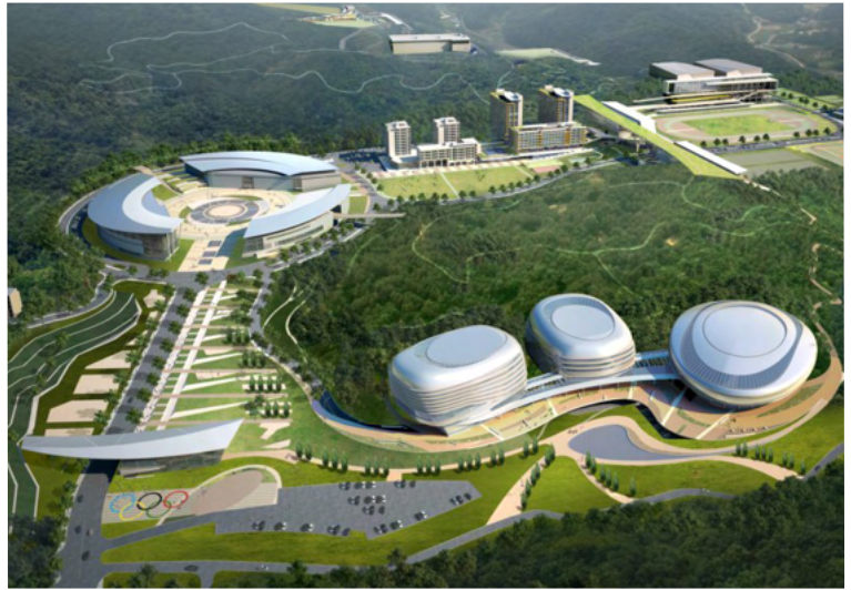
진천선수촌 2단계 2공구 방송설비
