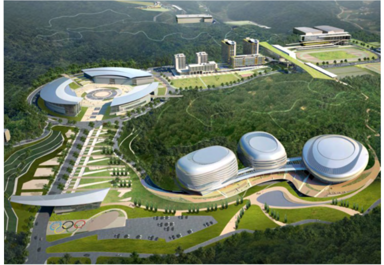
진천선수촌 2단계 2공구 방송설비
