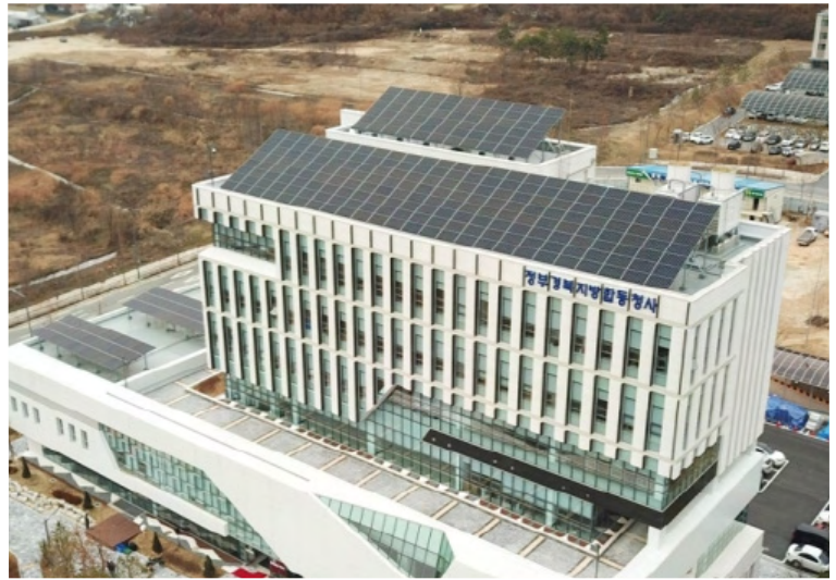
정부경북지방합동청사 관급자재 방송설비
